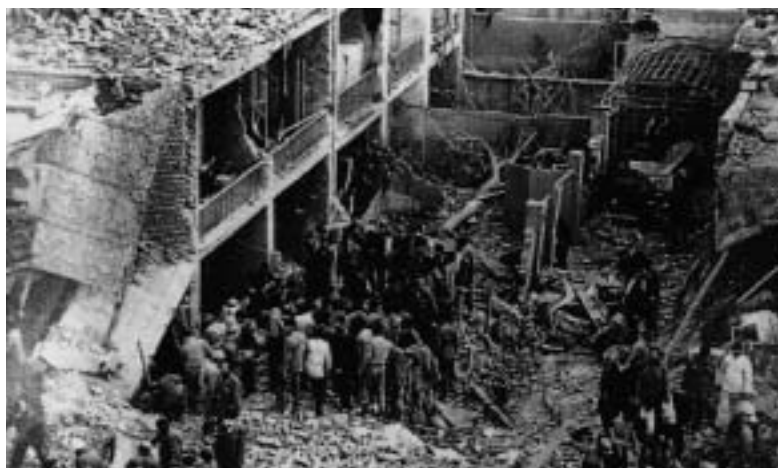
Impact d'un Al-Hussein irakien sur Téhéran (D.R.)
